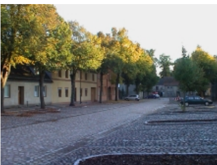
Die Klosterstraße nach der Sanierung/2002
