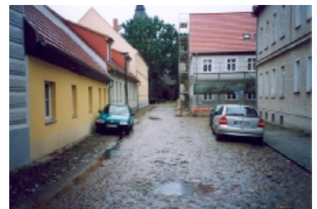
Die Kirchstraße vor der Sanierung/2002
