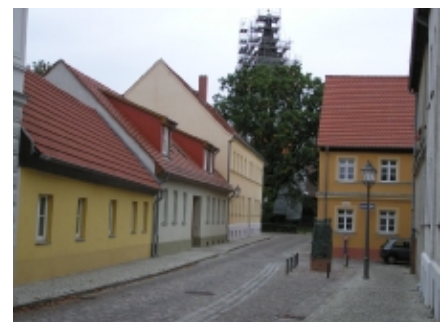
Die Kirchstraße nach der Sanierung/2004
