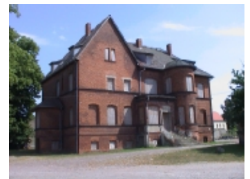
Gutshaus 2003 vor der Sanierung
