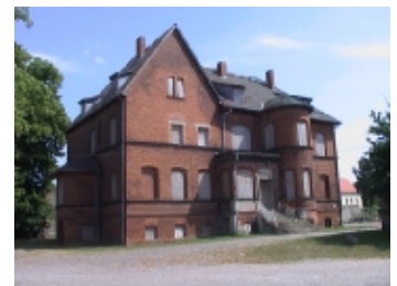
Gutshaus 2003 vor der Sanierung
