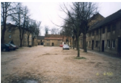
Die Klosterstraße vor der Sanierung /2000
