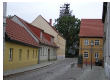
Die Kirchstraße nach der Sanierung/2004
